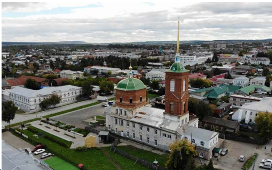
Рис. 6. Собор во имя Святой Троицы. Установлены купола. г. Красноуфимск.2018.г.
