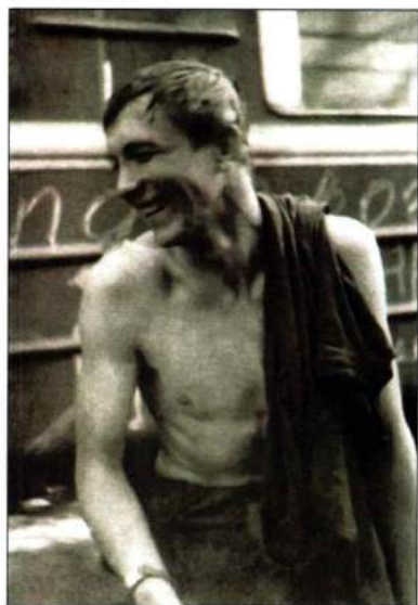
На строительстве газопровода Бухара – Урал. 1967 г.
